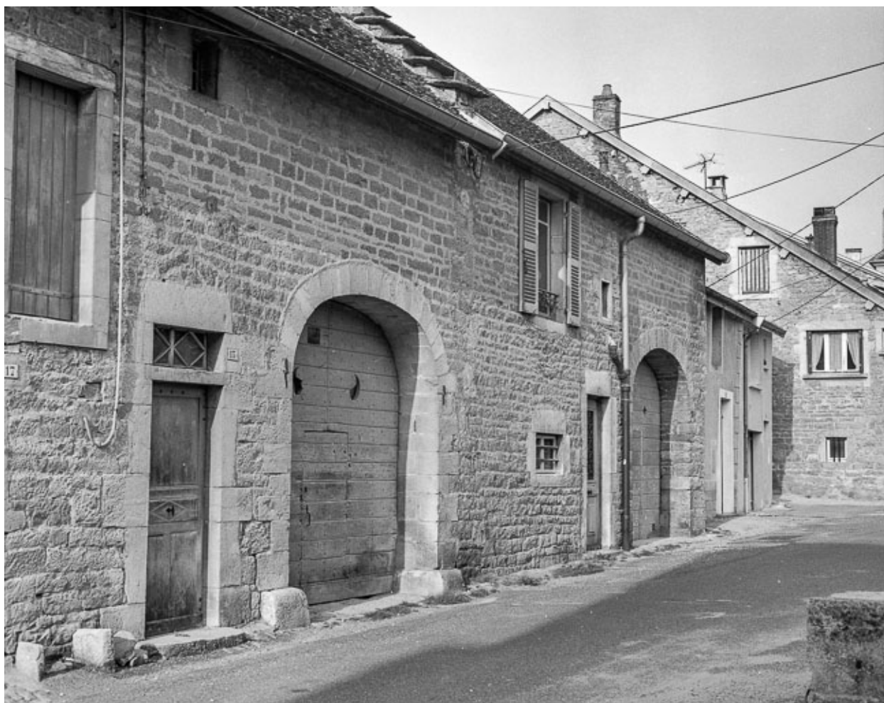
Maison de vigneron située 13-15 rue du Château.
