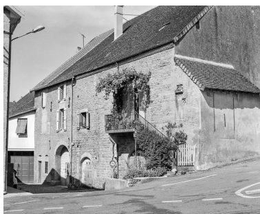
Maison de vigneron située 2 rue de la Batavarde. Phot. Dominique Dominguez IVR43_19803900175X
