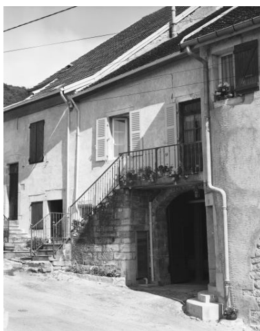
Maison de vigneron située 15 rue Saint-Jean-Baptiste. Phot. Dominique Dominguez IVR43_19803900177X
