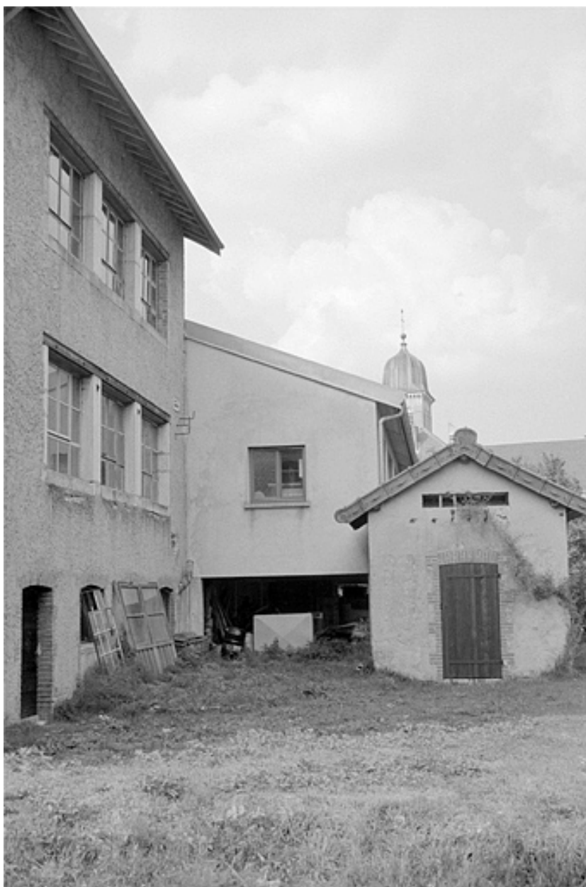
Façade postérieure et transformateur.
